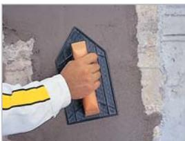
El acabado se realiza fratasando la superficie con una herramienta adecuada (fratás de plástico, madera, pórex...).
