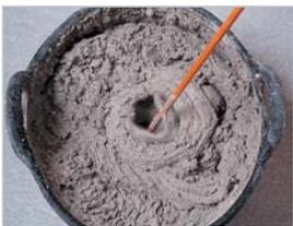
Amasar el producto con 4,5-5,5 litros de agua por saco, según la reología que se quiere obtener. Si se quiere obtener un mortero de carácter tixotrópico para su posterior aplicación con llana, utilizar entorno a 4,5 litros. Y para obtener un mortero de carácter fluido para aplicar con rodillo, amasar con entorno a 5,25 litros.
