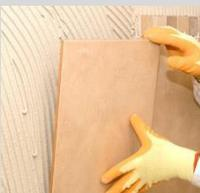
lijada superficialmente y haberse limpiado los residuos de polvo generados. Se recomienda el uso de la imprimación **weber.prim TP05** antes de la aplicación del mortero cola. En el caso de colocación de cerámica sobre soleras de calefacción radiante de anhídrita, usar los morteros cola flexibles y deformables **weber.col flex<sup>2</sup> multi** o **weber.col flex<sup>2</sup> multigel**.
